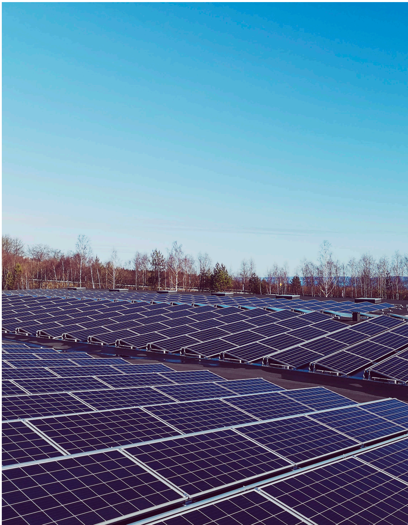
Bild: Solenergianläggningen installeras, Habo.
