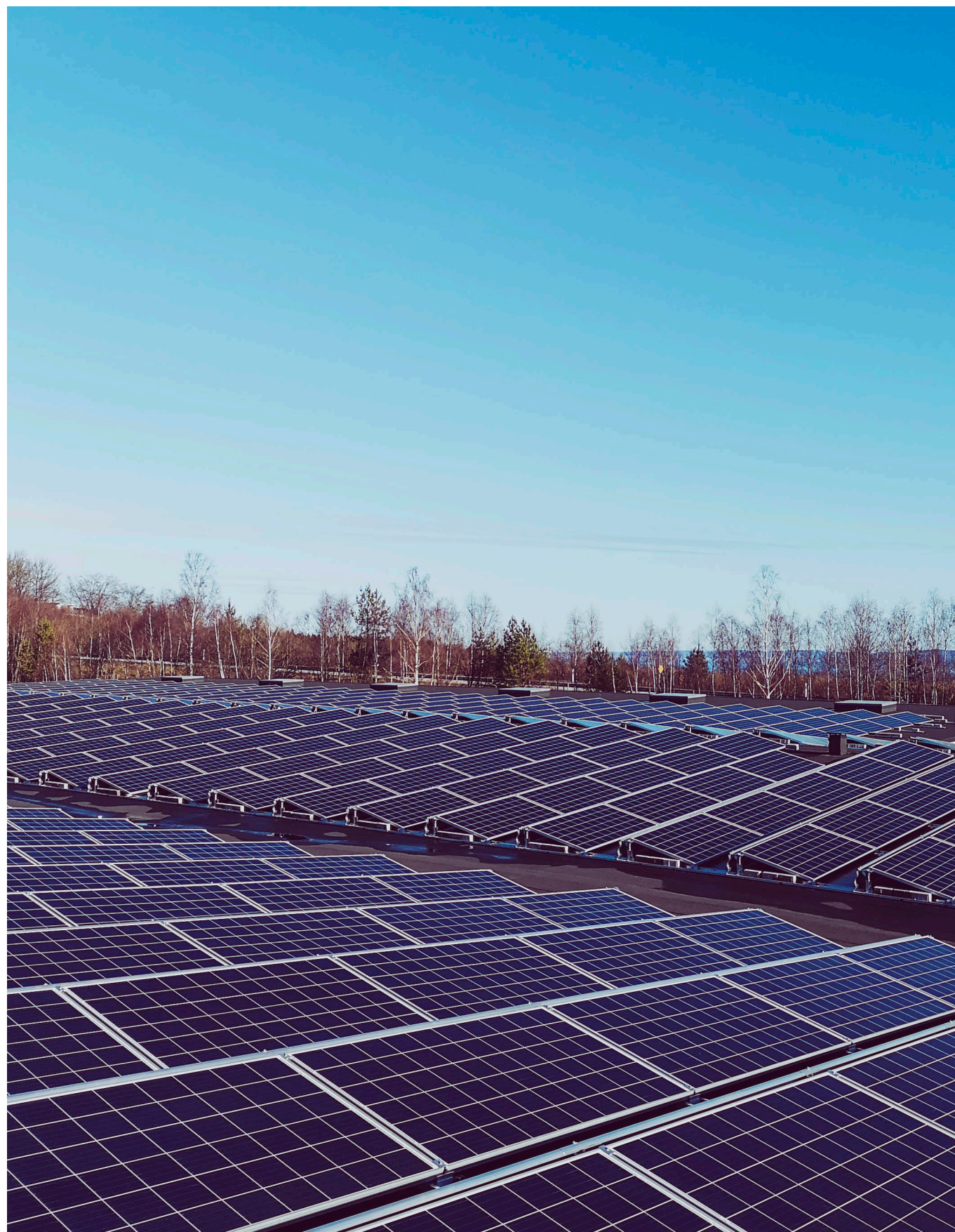
Bild: Solenergianläggningen installeras, Habo.
